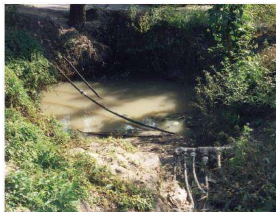
Foto 3.22 Insieme di condotte terziarie collegate alla rete secondaria nell'area di Manzese (Kjellen, 2006)
