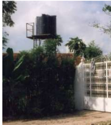
Foto 3.28 Serbatoio di immagazzinamento nell'area di Kinondoni (Kjellen, 2006)
