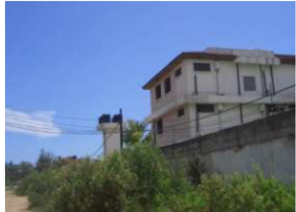
Foto 4.22 Edificio di 2 piani con 4 serbatoi di immagazzinamento dell'acqua. Area di Mikocheni
