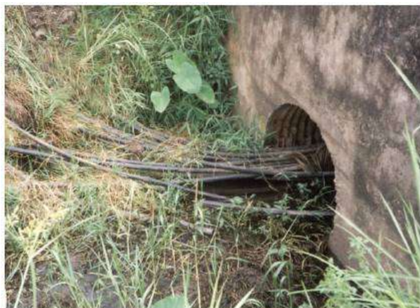
Foto 3.21 Fascio di condotte del sistema terziario nell'area di Mikocheni. Fenomeno della "spaghetizzazione" (Kjellen, 2006)
