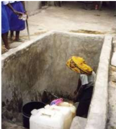
Foto 3.27 Rubinetto sotterraneo nell'area di Tandika (Kjellen, 2006)
