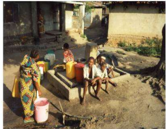
Foto 3.26 Recisione della condotta, per ovviare ad i problemi di bassa pressione (Kjellen, 2006)
