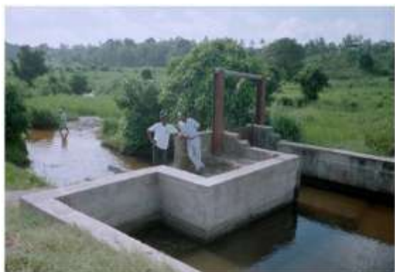
Foto 3.17 Struttura di presa, localizzata nei pressi di Mtoni, sul Fiume Kizinga (Kjellen, 2006)
