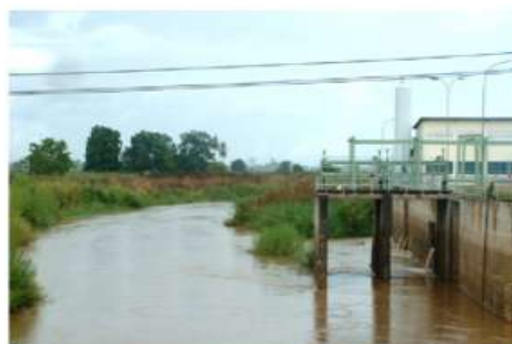
Foto 3.18 Struttura di presa Upper Ruvu, localizzata nei pressi di Mlandizi, sul Fiume Ruvu (Kjellen, 2006)
