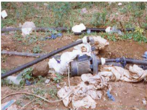
Foto 3.25 Booster pump in una abitazione a Msasani (Kjellen, 2006)
